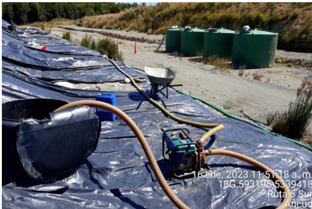
Fotografía N°2: Extracción de Lixiviados desde cámara C13. Tomada: Lunes 16 de Enero del 2023.
