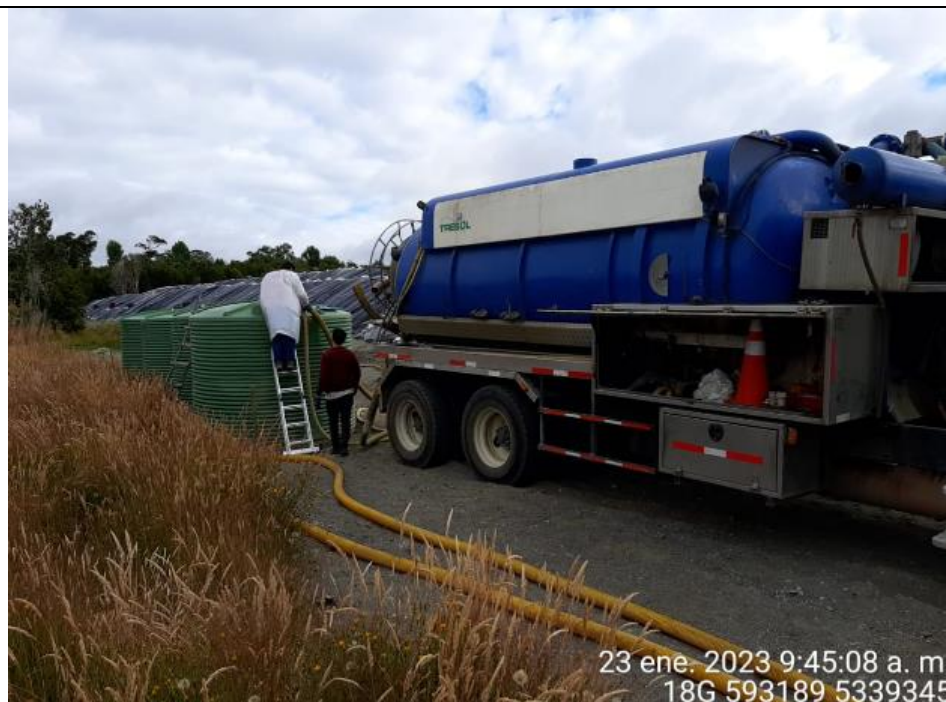
Fotografía N°15: Retiro de Lixiviados por empresa Tresol. Tomada: Lunes 23 de Enero del 2023.
