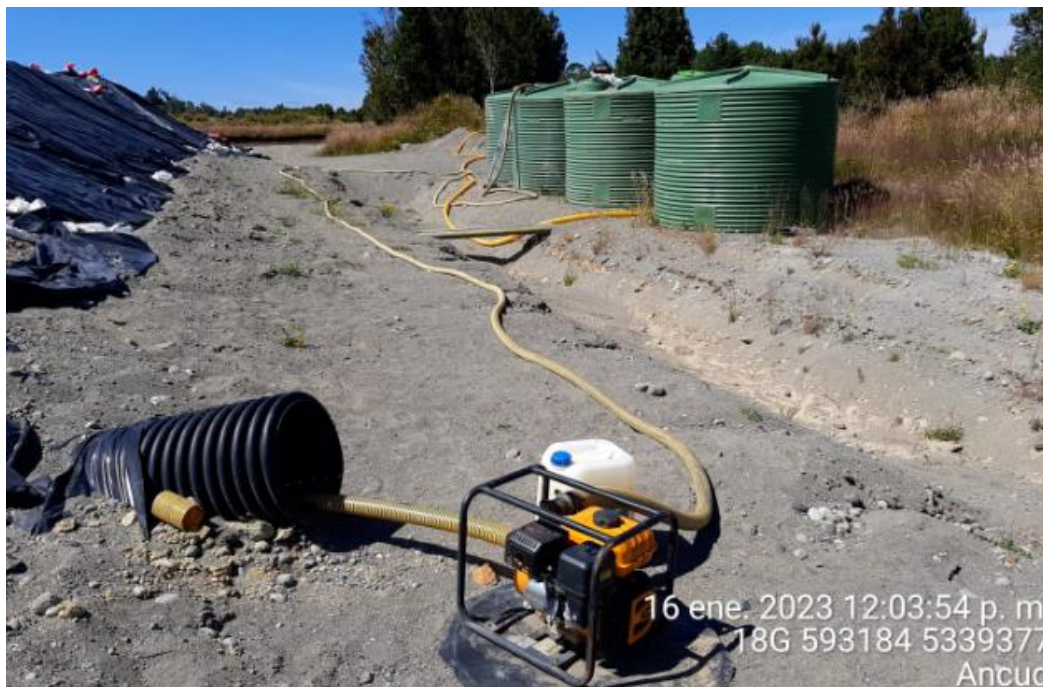
Fotografía N°4: Extracción de Lixiviados desde diagonal D02 por personal municipal. Tomada: Lunes 16 de Enero del 2023.
