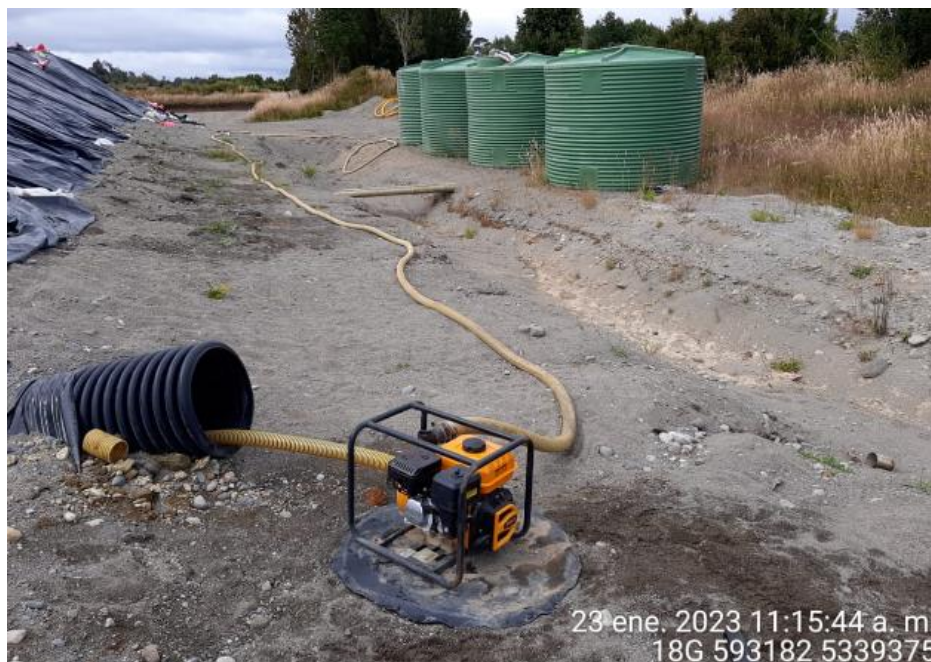
Fotografía N°13: Extracción de Lixiviados desde diagonal D02. Tomada: Lunes 23 de Enero del 2023.
