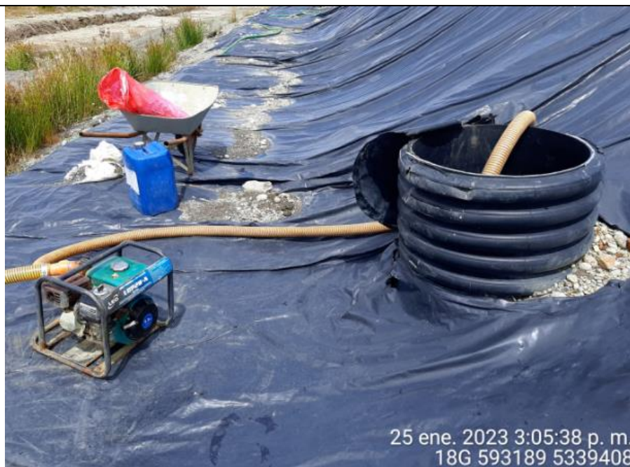
Fotografía N°17: Extracción de Lixiviados desde cámara C13. Tomada: Miércoles 25 de enero del 2023.
