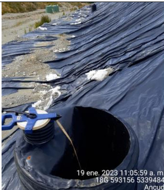
Fotografía N°30: Medición de Niveles de cámaras por Personal Municipal. Tomada: 19 de Enero del 2023.
