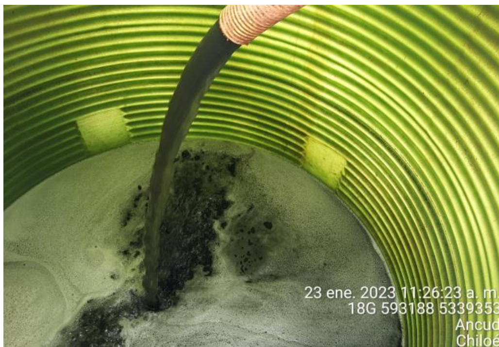
Fotografía N°14: Extracción de Lixiviados a estanque. Tomada: Lunes 23 de Enero del 2023.
