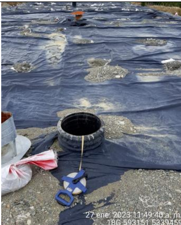
Fotografía N°36: Medición de Niveles de cámaras por Personal Municipal. Tomada: 27 de Enero del 2023.
