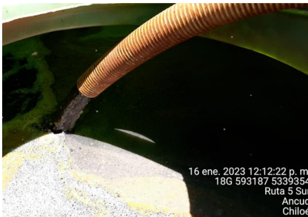
Fotografía N°5: Extracción de Lixiviados a estanque por personal municipal. Tomada: Lunes 16 de Enero del 2023.
