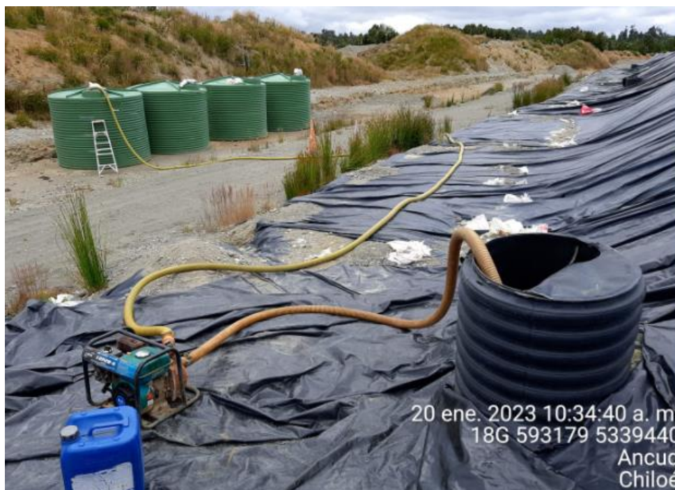
Fotografía N°10: Extracción de Lixiviados desde cámara C12. Tomada: Viernes 20 de Enero del 2023.
