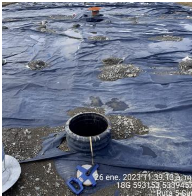
Fotografía N°35: Medición de Niveles de cámaras por Personal Municipal. Tomada: 26 de Enero del 2023.
