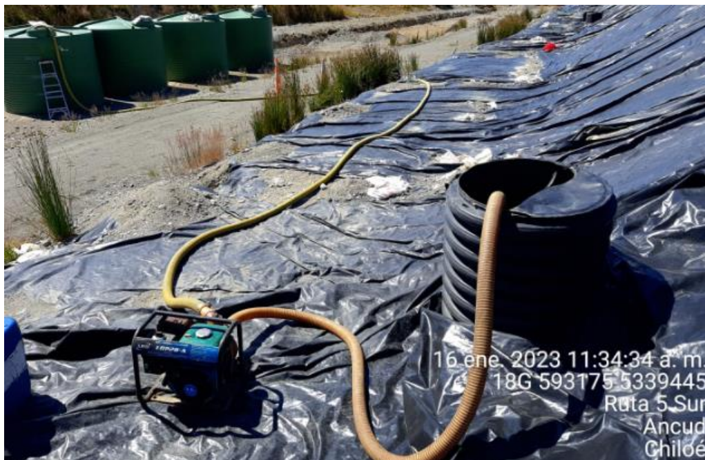
Fotografía N°1: Extracción de Lixiviados desde cámara C12. Tomada: Lunes 16 de Enero del 2023.
