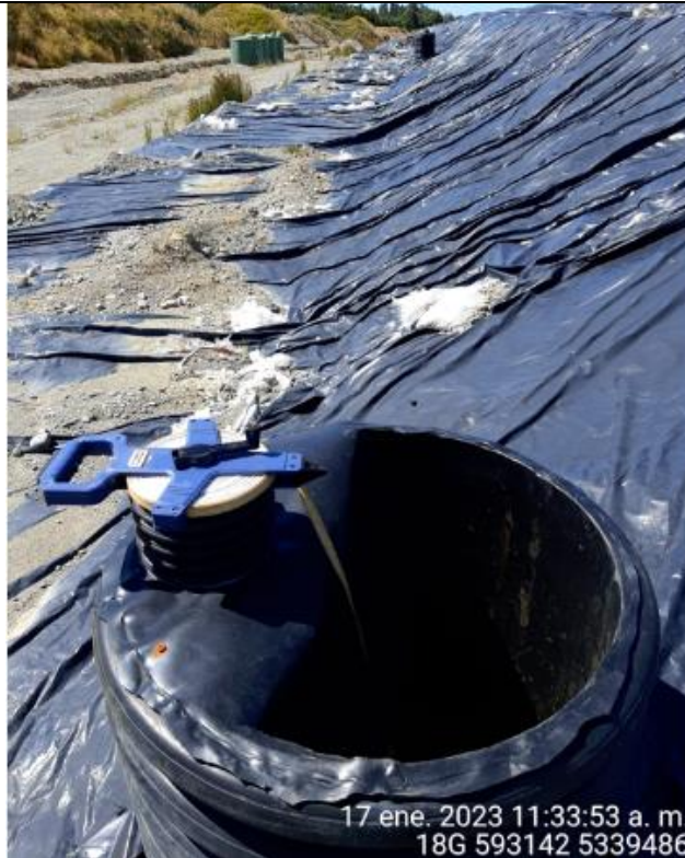
Fotografía N°28: Medición de Niveles de cámaras por Personal Municipal. Tomada: 17 de Enero del 2023.
