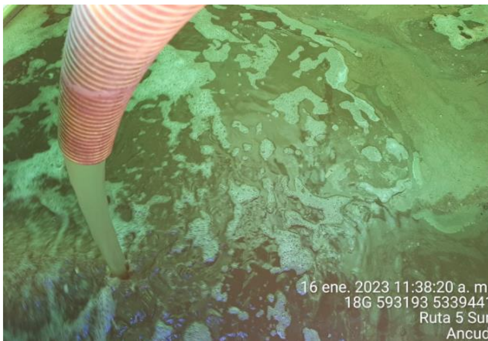
Fotografía N°3: Extracción de Lixiviados a estanque por personal municipal. Tomada: Lunes 16 de Enero del 2023.
