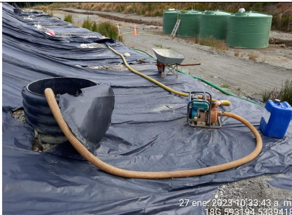
Fotografía N°24: Extracción de Lixiviados desde cámara C13. Tomada: Viernes 27 de Enero del 2023.
