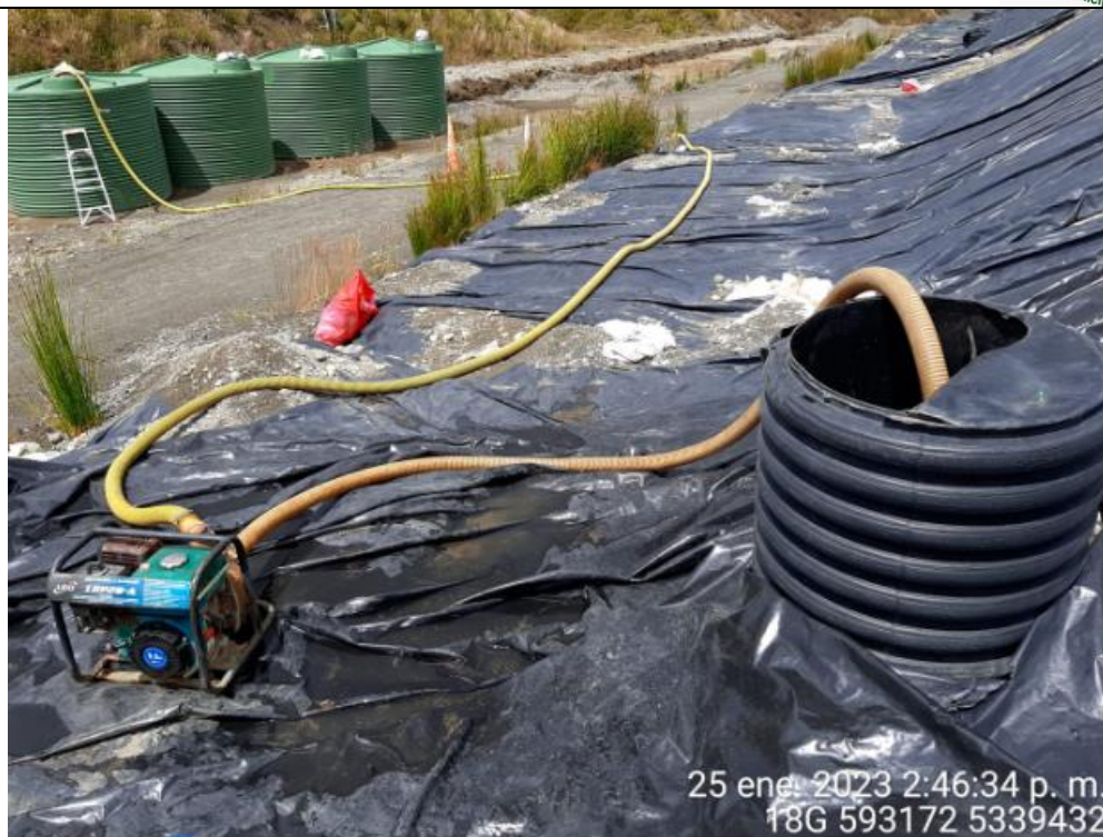
Fotografía N°16: Extracción de Lixiviados desde cámara C12. Tomada: Miércoles 25 de enero del 2023.
