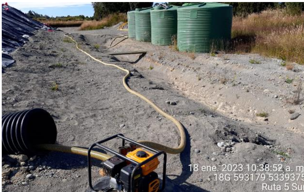
Fotografía N°6: Extracción de Lixiviados desde diagonal D02 por personal municipal. Tomada: Miércoles 18 de Enero del 2023.
