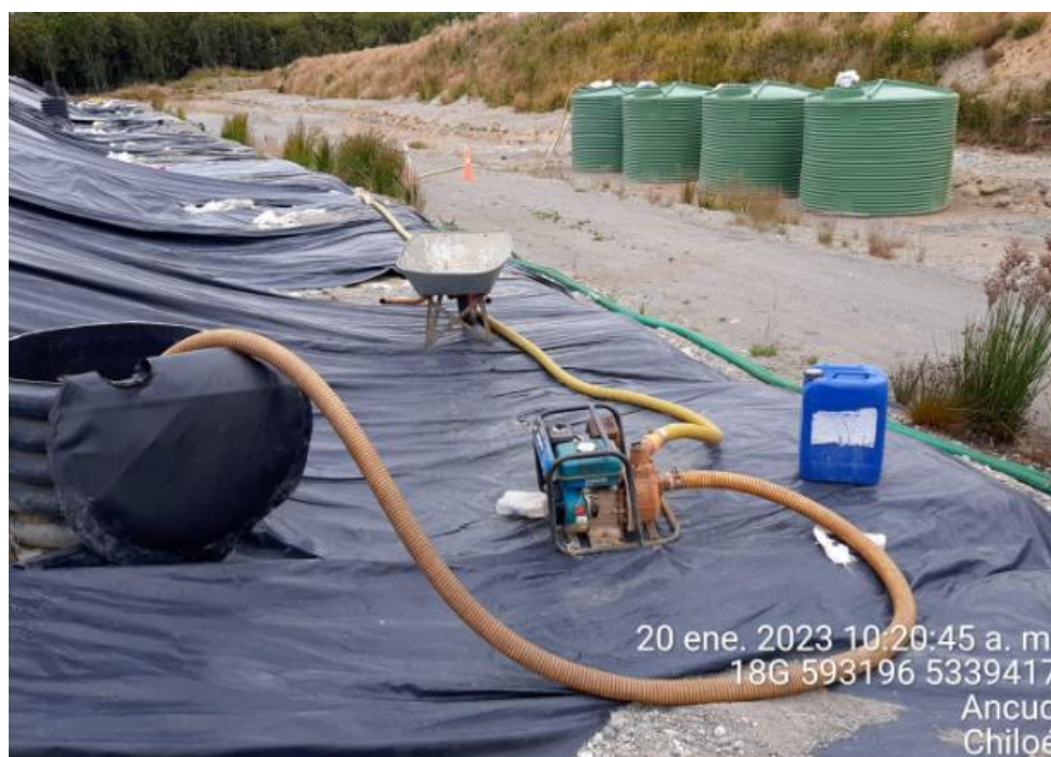
Fotografía N°11: Extracción de Lixiviados desde cámara C13. Tomada: Viernes 20 de Enero del 2023.
