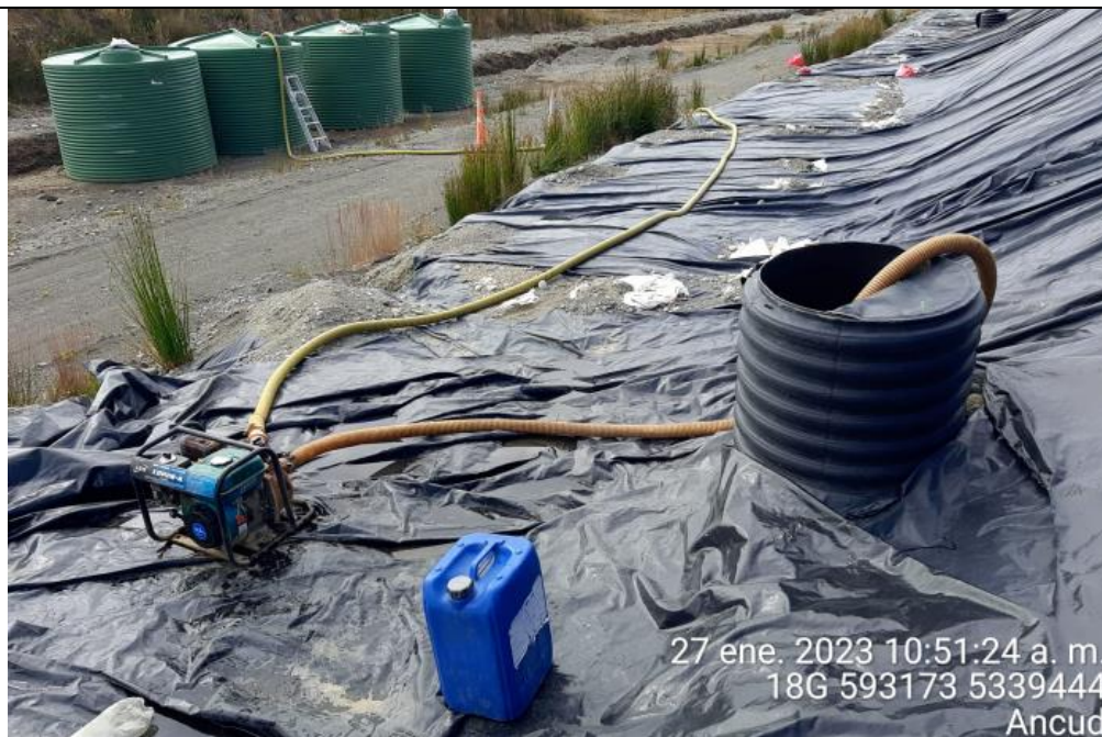
Fotografía N°23: Extracción de Lixiviados desde cámara C12. Tomada: Viernes 27 de Enero del 2023.
