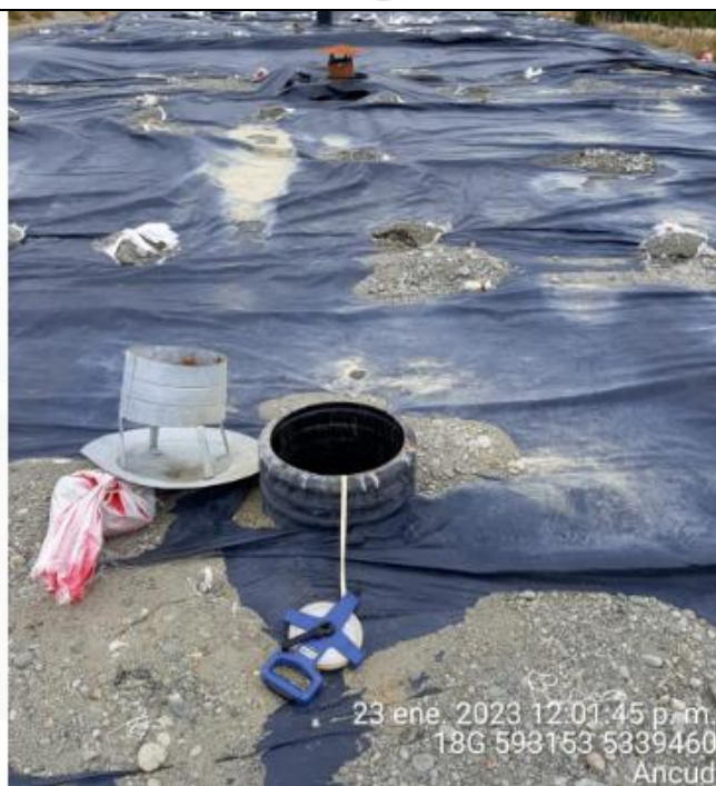
Fotografía N°32: Medición de Niveles de cámaras por Personal Municipal. Tomada: 23 de Enero del 2023.
