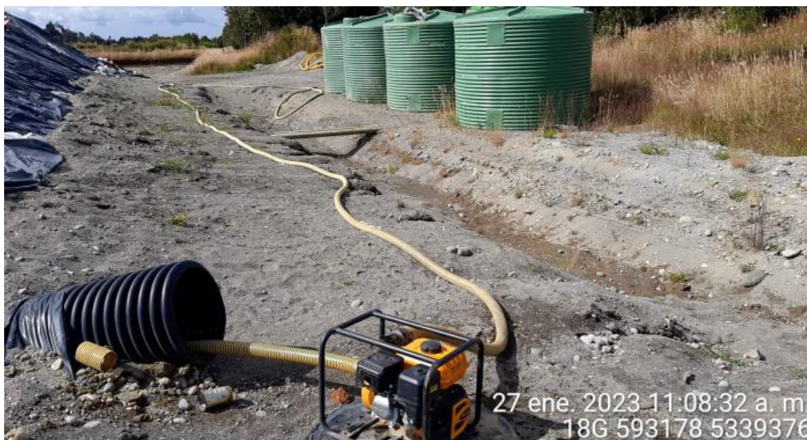
Fotografía N°21: Extracción de Lixiviados desde diagonal D02. Tomada: Viernes 27 de Enero del 2023.
