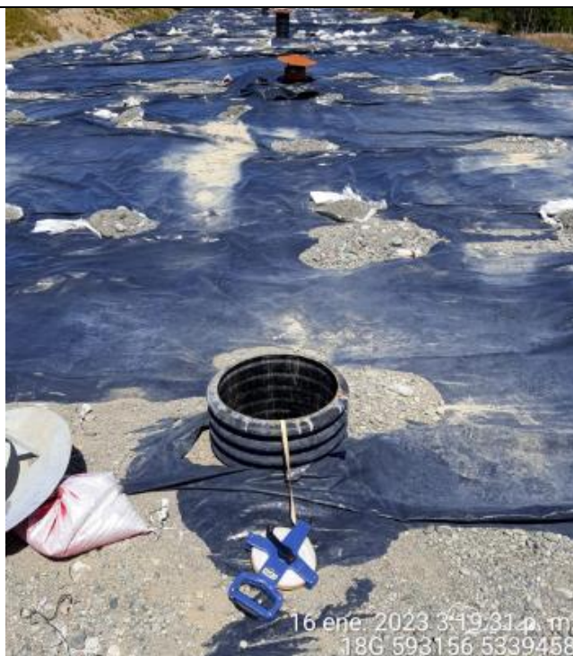
Fotografía N°27: Medición de Niveles de cámaras por Personal Municipal. Tomada: 16 de Enero del 2023.
