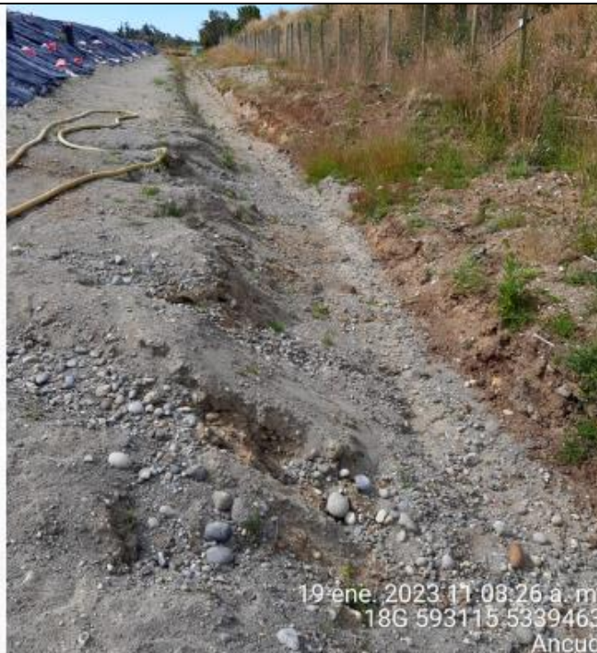
Fotografía N°40: Estado canales aguas lluvias
